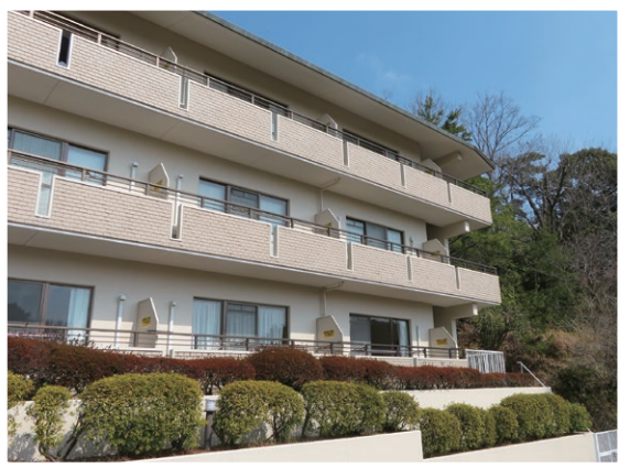
外壁改修中の様子
